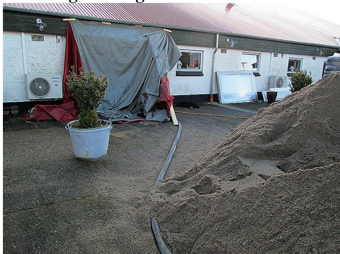
Betonen pumpes ind
