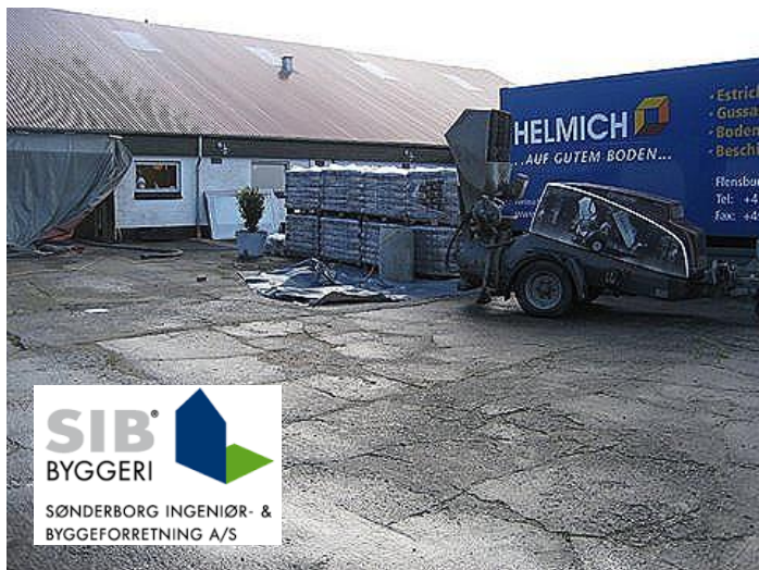
Støbefirmaet er kommet
