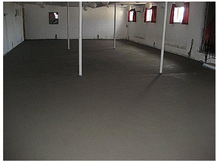
Den 24. februar. Færdig arbejde.
