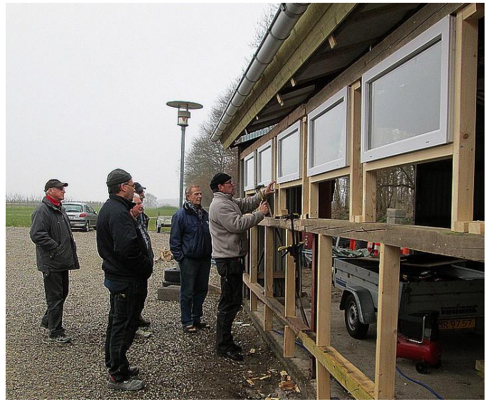
Vinduer monteres under kyndig opsyn.
