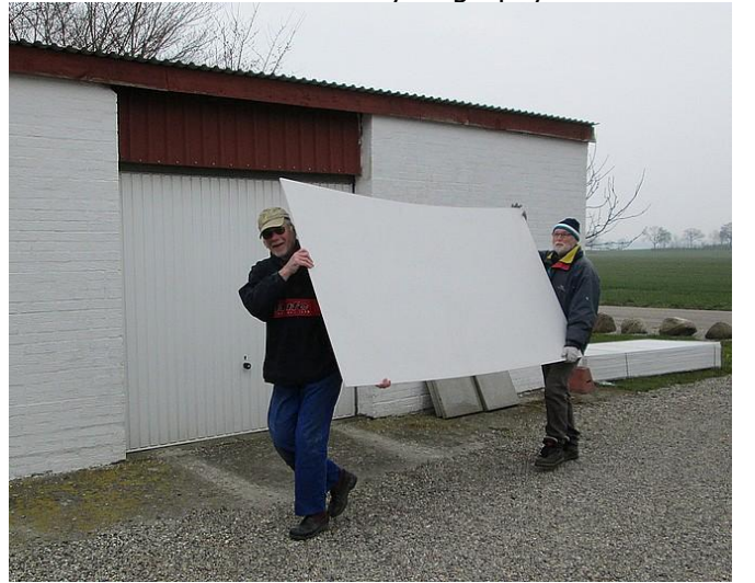
Det første fasadeelement bliver leveret.
